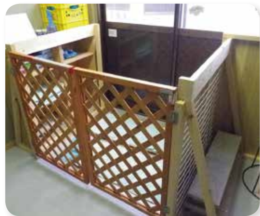
出入り口には逸走防止の柵を設置
